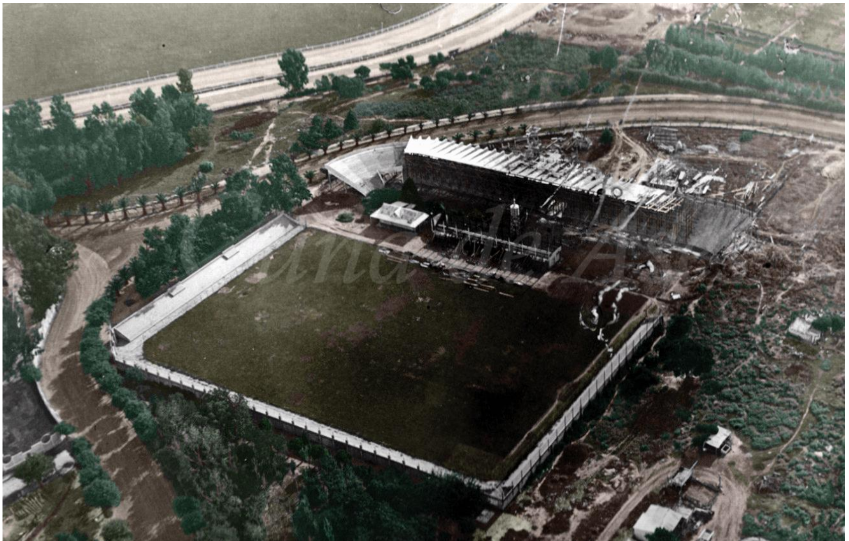
Newell's Old Boys 1929. Etapa final de construcción de la Tribuna de la Visera, y desmantelamiento de la Vieja oficial de madera. Créditos a quien corresponda.
